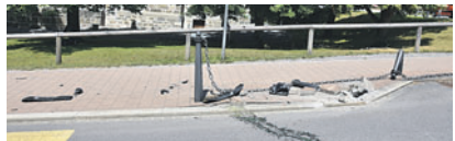
Dieser Lieferwagen beschädigte diese Pfosten in Schaan. (Fotos: LPFL)
